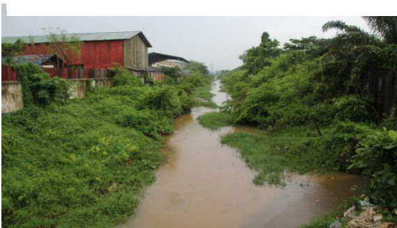
G. Wastewater Canal
