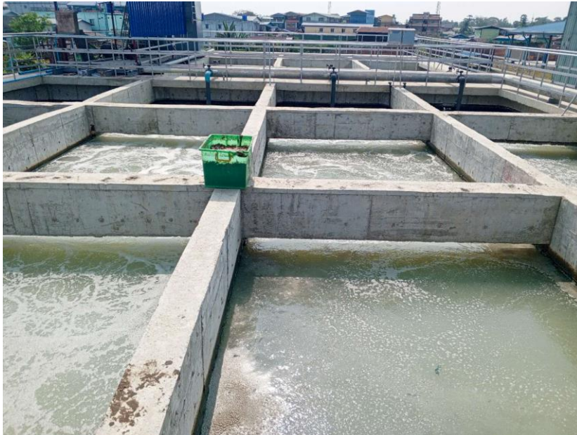
ပုံ (16) Teng Hui (Myanmar) Knitting Company Limited ၏စွန့်ပစ်ရေသန့်စင်မှုစနစ်တွင်အသုံးပြုသော အနည်ထိုင်ကန်
