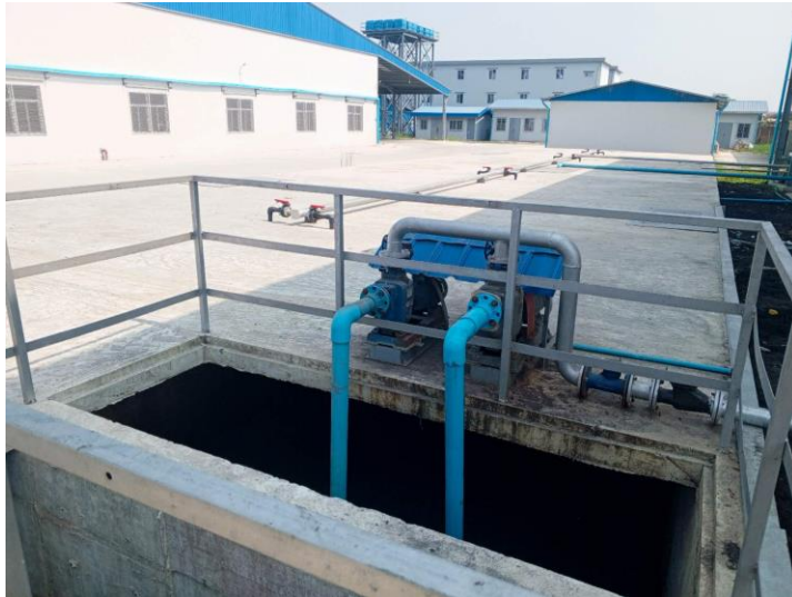
ပုံ (14) TENG HUI (MYANMAR) KNITTING COMPANY LIMITED ၏ စက်ရုံမှ ထွက်ရှိသော လုပ်ငန်းသုံးရေ၊ အထွေထွေစွန့်ပစ်ရေများကို စွန့်ပစ်ရေသန့်စင်မှုသို့ သီးခြားပိုက်လိုင်းသွယ်တန်းထားရှိမှု
