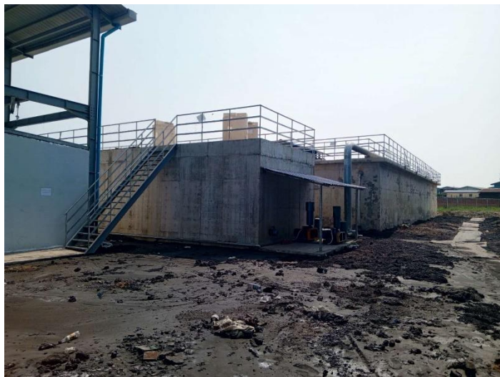
ပုံ (15) TENG HUI (MYANMAR) KNITTING COMPANY LIMITED ၏ စက်ရုံမှ ထွက်ရှိသော လုပ်ငန်းသုံးရေ၊ အထွေထွေစွန့်ပစ်ရေများကို လက်ခံထားရှိသောကန်
