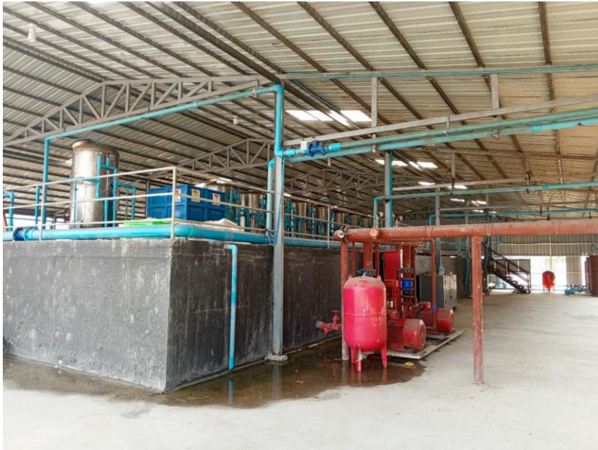
ပုံ(8) Teng Hui (Myanmar) Knitting Company Limited ၏ ရေသိုလှောင်ကန်
