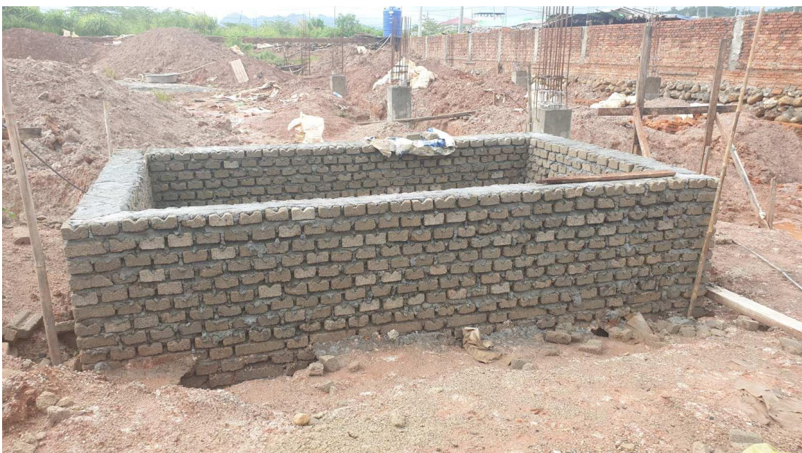
ပုံ(6) ကွန်ကရစ်ရေကန် ဖြင့်သိုလှောင်ရန်တည်ဆောက်နေပုံ
