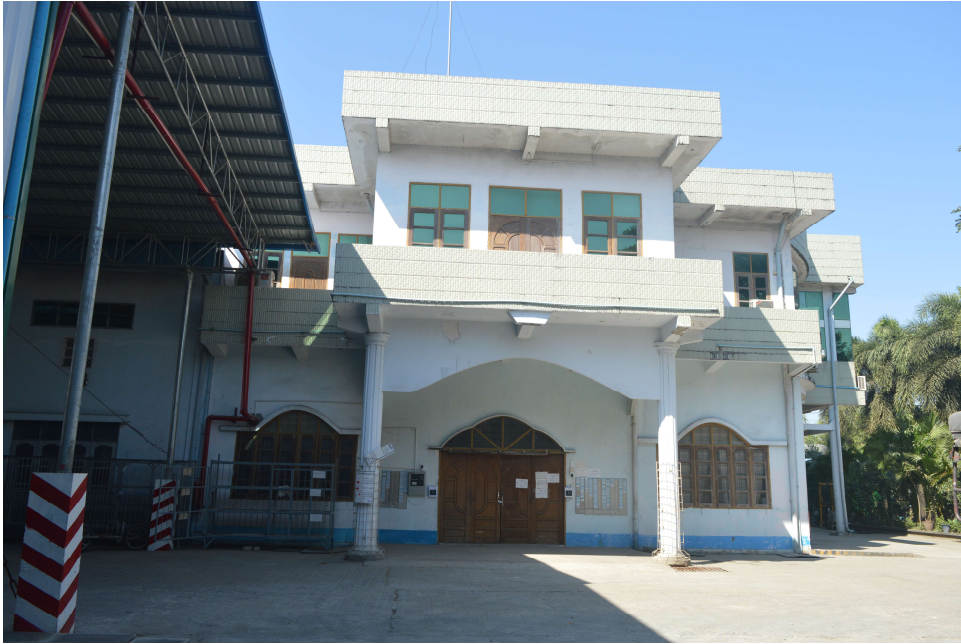
Figure 3.5 စက်ရုံရုံးခန်းအဆောက်အဦး
