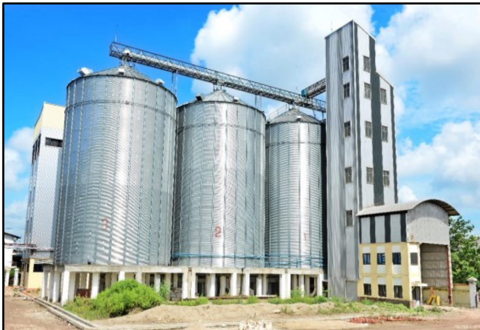
ပုံ (၄.၆) ဂျုံစေ့လှောင်ကန် (Silo)
