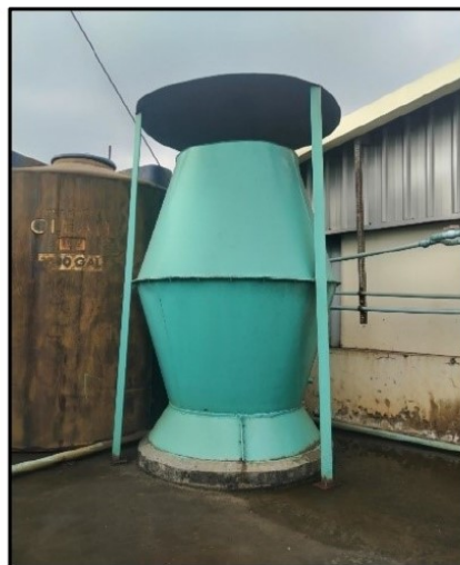
ပုံ (၁၅) Dust Air-jet Filter
