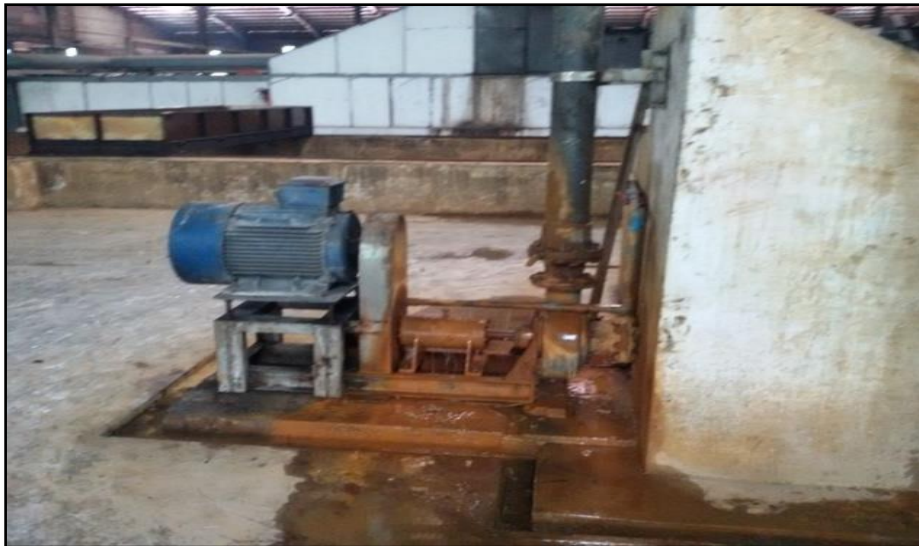
ပုံ(၄-၁၃-၁၁) Vortex Transfer Pump ပုံ
