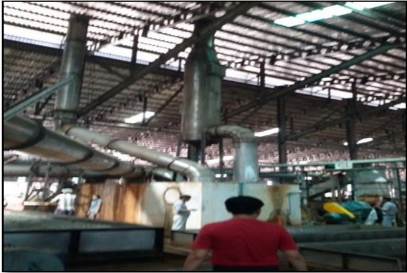
ပုံ (၆-၂) Air Scrubber အထွက်ခေါင်းတိုင်သို့ပိုက်လိုင်းများ သွယ်တန်းထားပုံ
