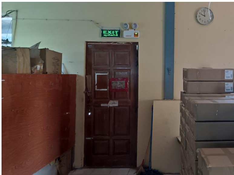
အရေးပေါ်ထွက်ပေါက် နှင့် အရေးပေါ်မီးထားရှိမှု
