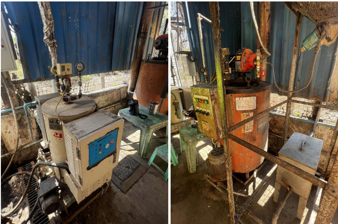
ပုံ ၅-၂၁ လျှပ်စစ်ဘွိုင်လာ (ဘယ်ပုံ) နှင့် ဒီဇယ်ဘွိုင်လာ (ညာပုံ) တို့အား တွေ့မြင်ရပုံ
