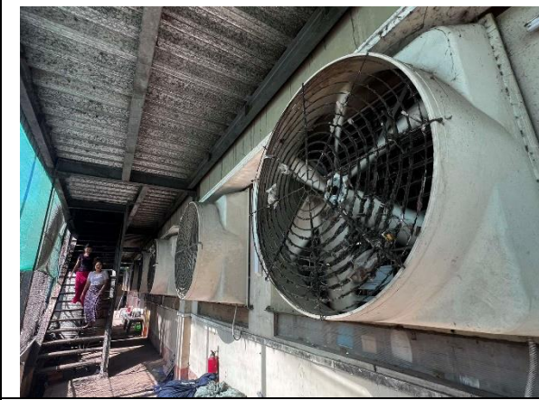
လေဝင်လေထွက် ကောင်းမွန်စေရန် ပန်ကာများဆောင်ရွက်ထားမှု
