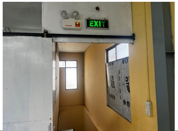
အရေးပေါ်ထွက်ပေါက်ဆောင်ရွက်ထားမှု
