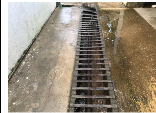
ရေစီးရေလာကောင်းမွန်စေရန် စက်ရုံတွင်း ရေမြောင်းစနစ်များဆောင်ရွက်ထားရှိခြင်း
