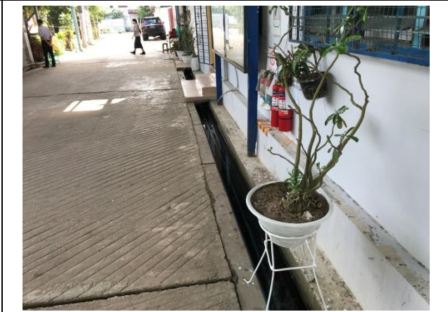
ရေစီးရေလာကောင်းမွန်စေရန် စက်ရုံတွင်း ရေမြောင်းစနစ်များဆောင်ရွက်ထားရှိခြင်း
