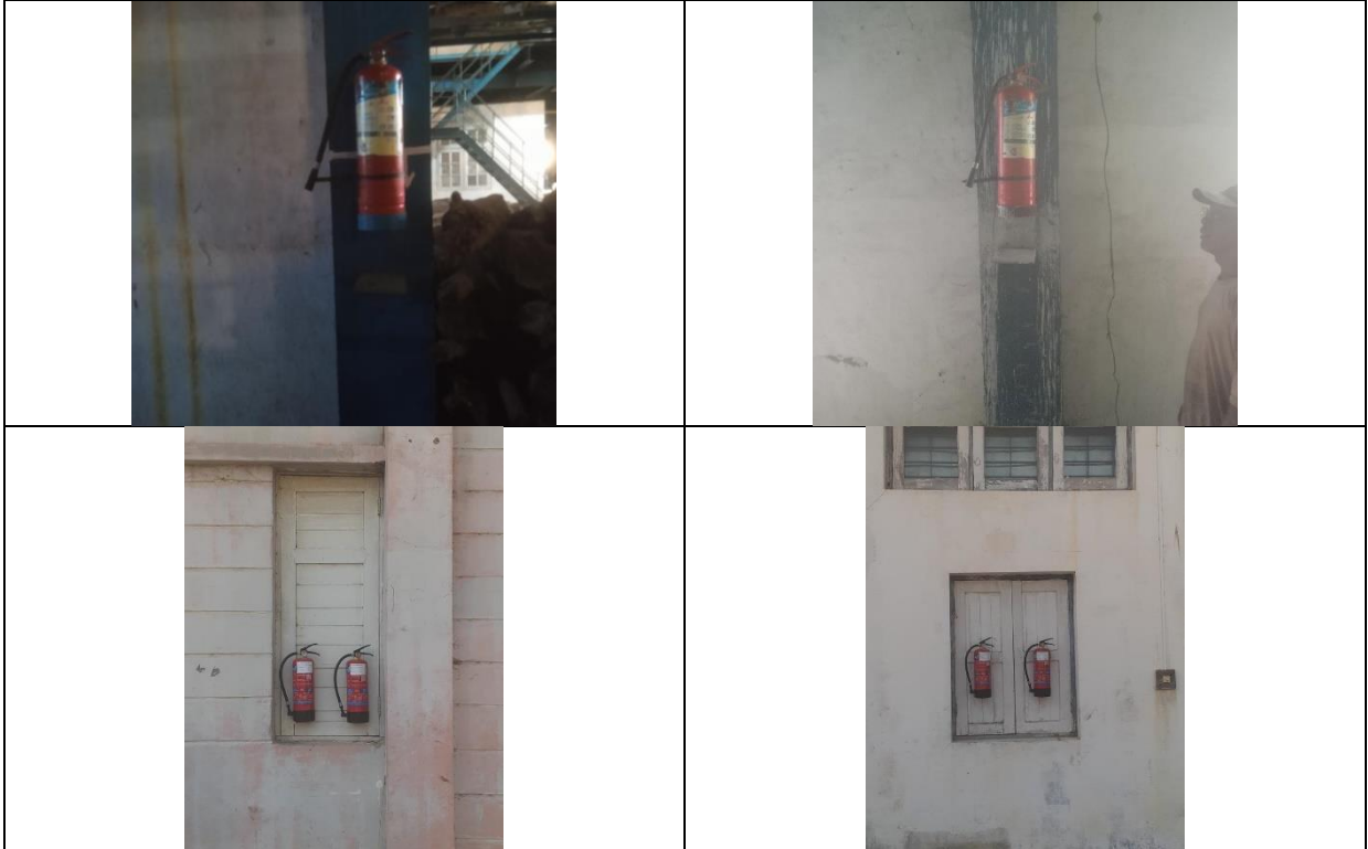
ပုံ ၇.၁ - စက်ရုံတွင်း မီးသတ်ဆေးပူးများထားရှိထားမှု အခြေအနေ
