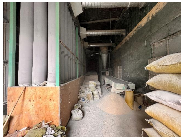
ပုံ ၄-၂၃ အမှုန်စုပ်စက် (Dust Collector) များ တပ်ဆင်ဆောင်ရွက်ထားမှုပြပုံ
