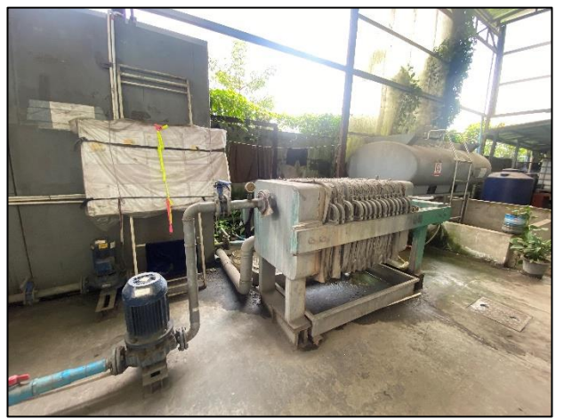
Electromagnetic Flow Meter နှင့် အနည်အနှစ်ညှစ်စက်
