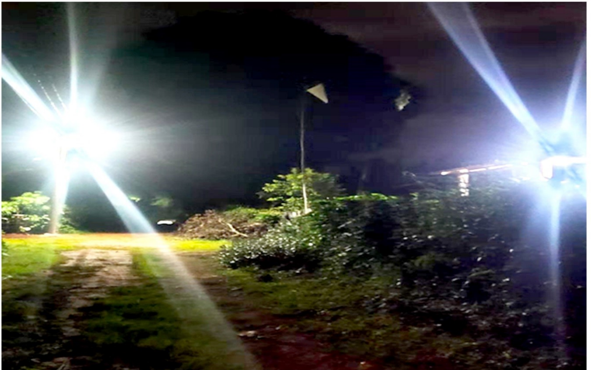
ဆင်တော်ကျေးရွာ မီးလင်းရေး ဆောက်ရွက်ထားရှိခြင်း
