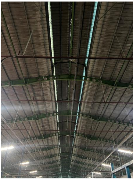
သဘာဝအလင်းရောင် ရရှိစေရန် ဆောင်ရွက်ထားမှု
