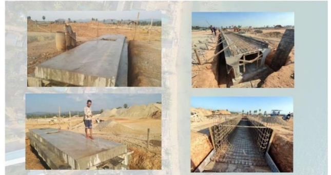
BOX CULVERT တည်ဆောက်ခြင်းလုပ်ငန်း
