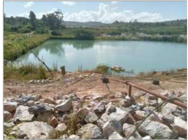
(d) Rainwater Storage Pond
