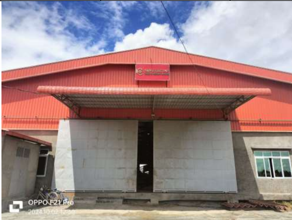
ပုံ 4-3 ပင်မစက်ရုံအဆောက်အဦပုံ
